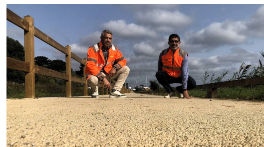
Yannick Hervieux et Pascal Delalande ont profité de l'inauguration de la voie verte autour du marais de Pen Mané, à Locmiquélic, pour présenter l'Urbalith, le revêtement utilisé lors de la réalisation de la chaussée.
